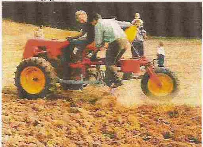
Der Unitrak bei Pflügevorfürungen. Der Boden war hier allerdings so trocken und hart, so dass nur mit einem Zusatzgewicht auf dem Pflug geackert werden konnte.
